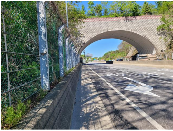
낙석방지울타리 및 하부 전경
