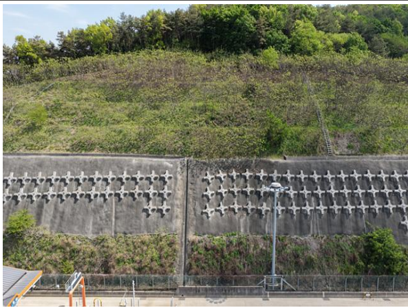
-shot크리트, 격자앵커블럭, 수직도수로 전경
