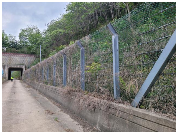
낙석방지울타리 및 하부 전경
