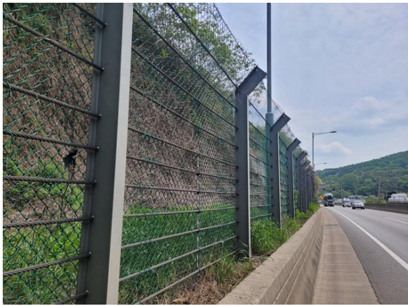
낙석방지울타리 및 하부 전경
