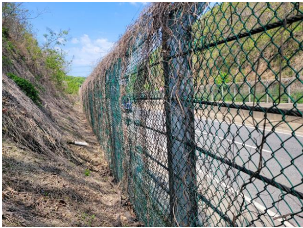
낙석방지울타리 및 하부 전경
