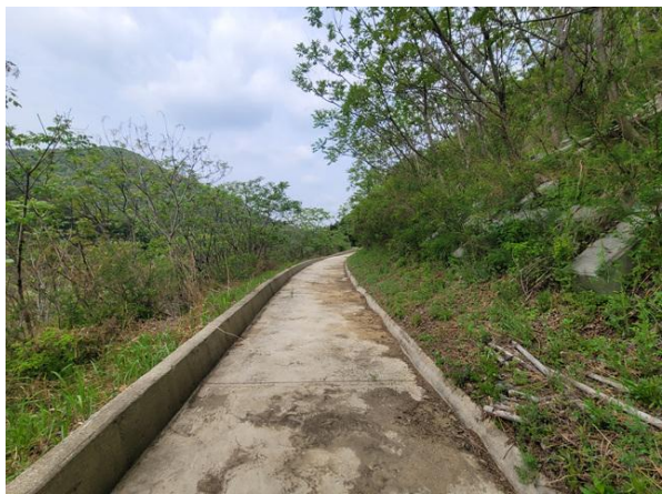
소단 배수로 전경
