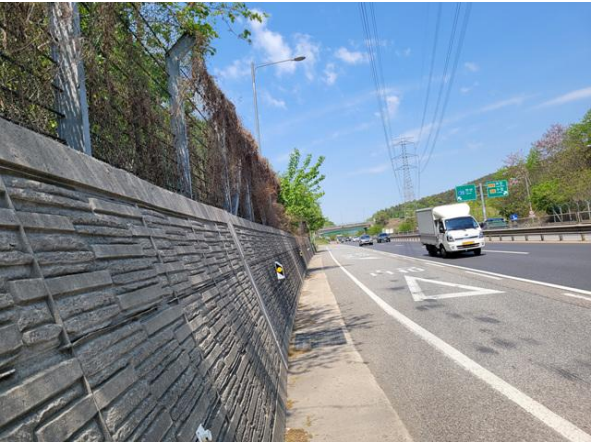
낙석방지울타리, 도로 전경
