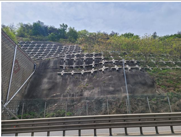
슛크리트, 격자앵커블럭 전경
