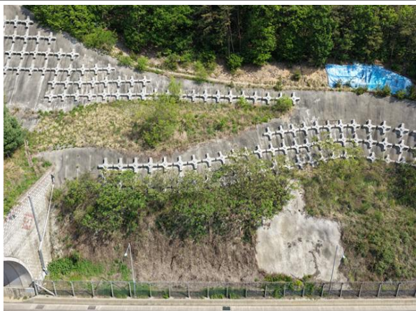
격자앵커블럭, 숏크리트 전경
