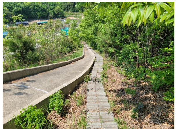
산마루측구, 점검계단 전경
