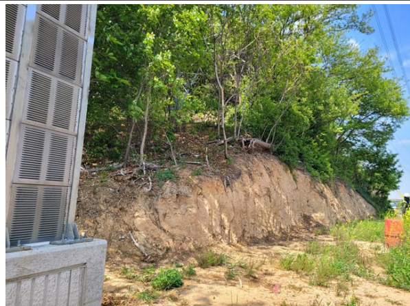
중점측 전경 (공사중, 수원국토관리구간)
