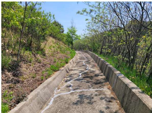
소단 배수로 전경
