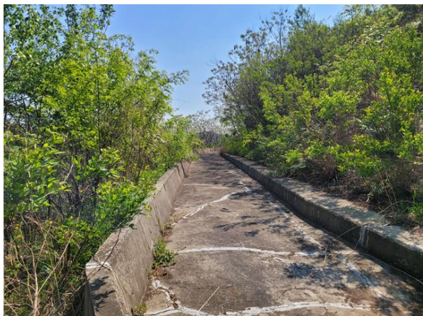
소단 배수로 전경
