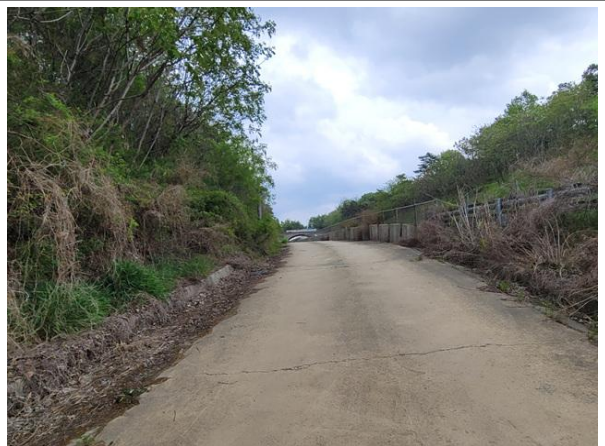
하부 도로 전경
